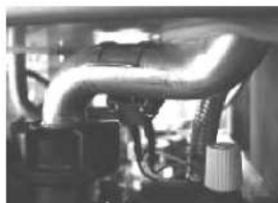
ДАТЧИК КОНТУРУ ЦЕНТРАЛЬНОГО ОПАЛЕННЯ
